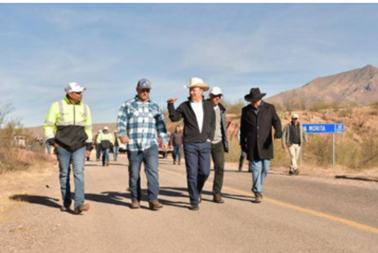
El gobernador Alfonso Durazo supervisa obras previas a la visita del presidente López Obrador a la sierra alta Foto: Cortesía | Gobierno del Estado
