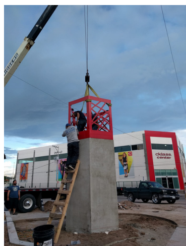
Durante el montaje de la estructura
