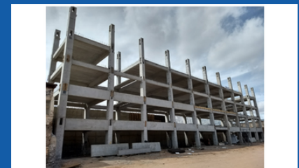
Edificio prefabricado durante su montaje destinado a aulas en la ciudad de Nogales, Sonora.
