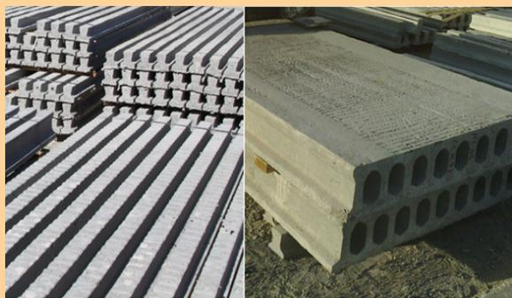
Acabado rugoso en la parte superior de elementos pretensados.
