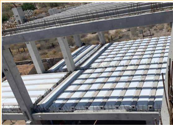
Losa a base de vigueta y bovedilla
