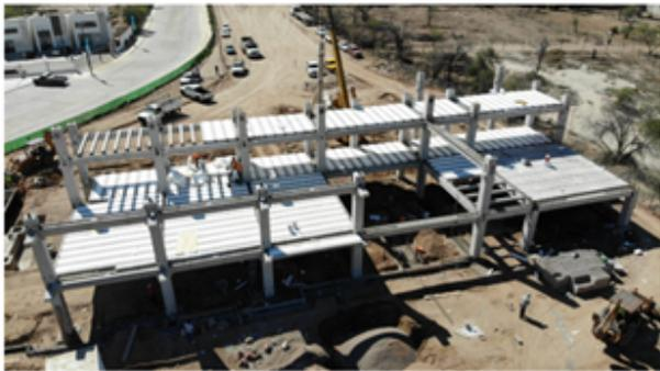
Edificio con columnas, traveses y losas prefabricadas de concreto.
